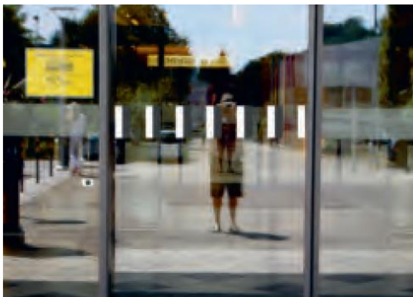
Obr. Príklad odlišného, vizuálne kontrastného označenia vstupných dverí v zasklenej stene
