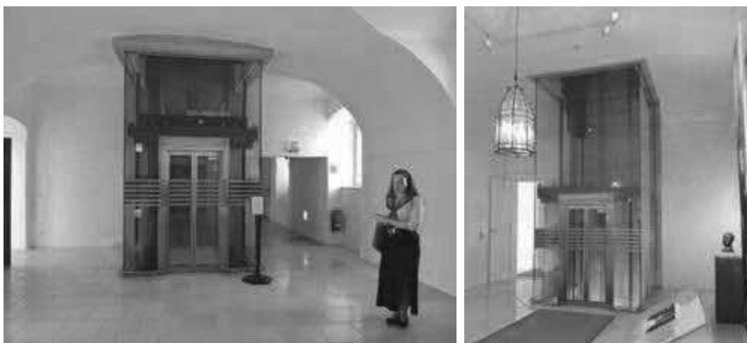
Obr.3) Teleso výťahu na prízemí zámku, prestup cez klenbu do 2NP b) Teleso výťahu na 2NP. Realizácia z prvej fázy obnovy. Poloha bola určená logicky pri nástupnom schodišti do celej miestnosti, čím sa dosiahlo potrebné veľkorysé predpolie a zostalo celistvé vnímanie priestoru. Foto T.Varga, 08/2020.
