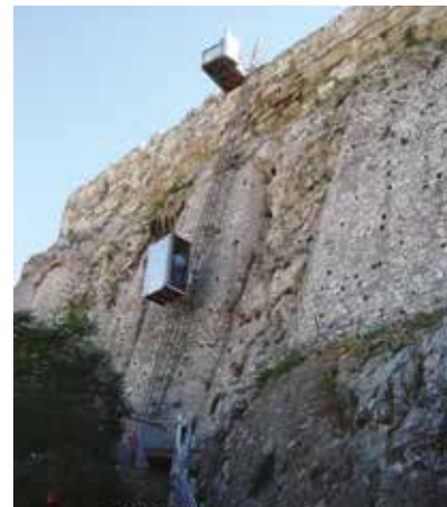
Obr. 6 Súčasný bezbariérový prístup do areálu Akropoly Zdroje: http://www.disabledtravelersguide.com/travel/travel_greece.htm
