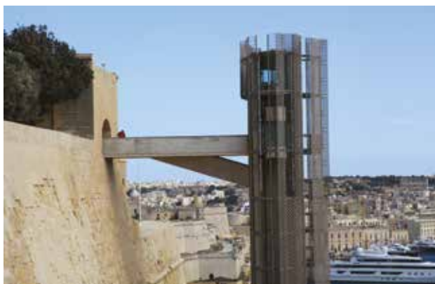
Obr. 3 Realizácia: Železobetónové jadro s transparentným oceľovým plášťom vyúsťuje nad pôvodnú hradbu do objektu záhrad. Splňa prísnu podmienku nezasahovania do historického opevnenia – je kotvené len v dolnej časti a pri vyústení. Zdroj: Wikimedia Commons
