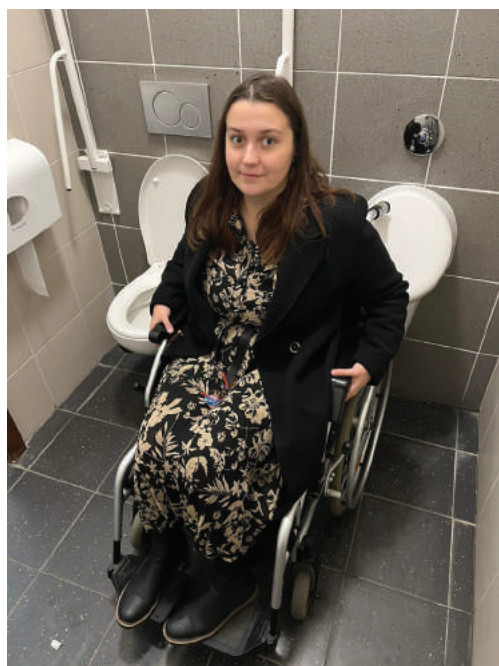
v bezbariérovej toalete problémový priestor pre odloženie vozíka kvôli pisoáru, ktorý do priestoru zasahuje
