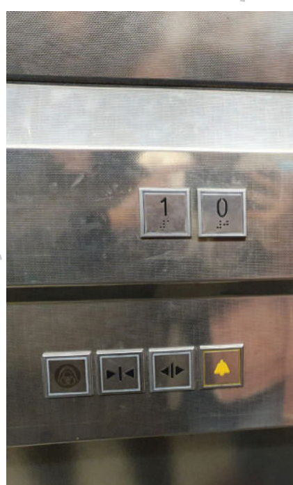
DETAIL VÝŤAHU NEVHODNÉ UMIESTNENIE BRAILLOVÉHO PÍSMO NA TLAČIDLÁCH
