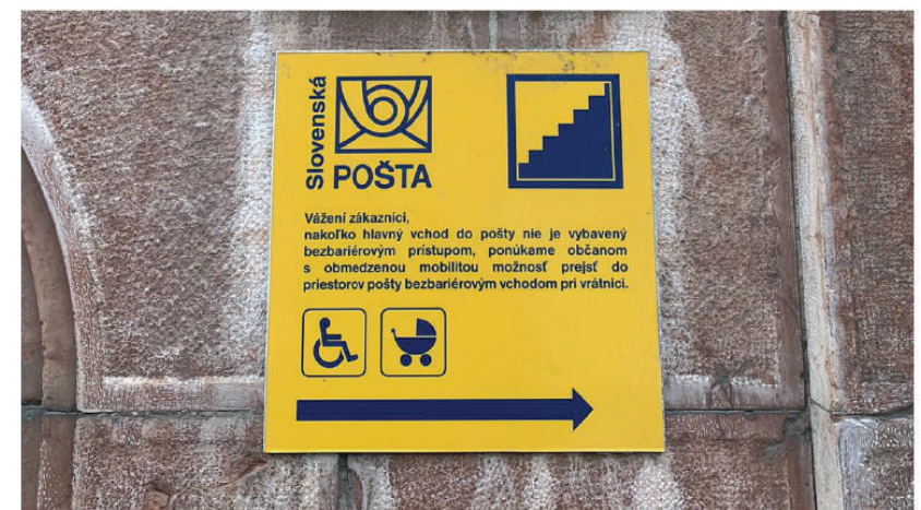
VSTUP_ OZNAČENIE BEZBARIÉROVÉHO VSTUPU CEZ VEDĽAJŠÍ VCHOD
