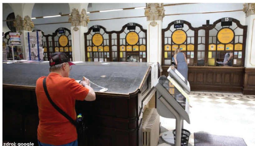
PREPÁŽKY_ VÝŠKA PULTU NA VYPISOVANIE Tlačív A HĽBKA PULTU PRI PREPÁŽKACH NIE SÚ PRISPÔSOBEŇE OSOBNám NA INVALIDNOM VOZÍKU
