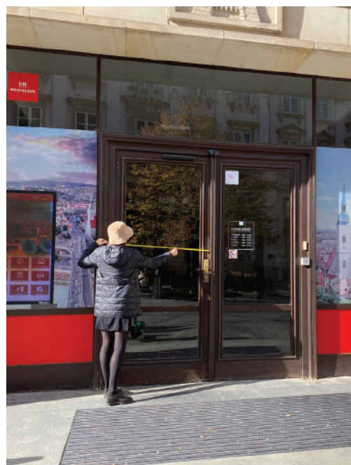
šírka otváracieho krídla dverí - 1000 mm, dvere sú otváracie automaticky
