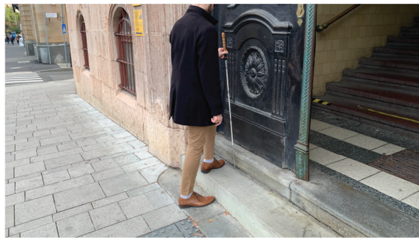
SCHODISKO A UMIESTNENIE DVIER_ HLAVNÉ SCHODISKO JE NEDOSTATOČNE OZNAČENÉ A VSTUPNÉ DVERE SÚ UMIESTNENÉ Priamo NA SCHODE
