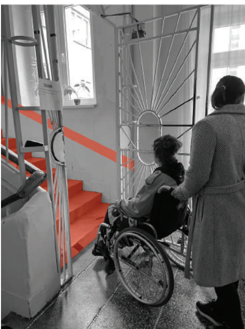
SCHODY AKO BARIÉRA VO VNÚTORNÝCH PRIESTORCH, CHÝBA ZÁBRADLIE
