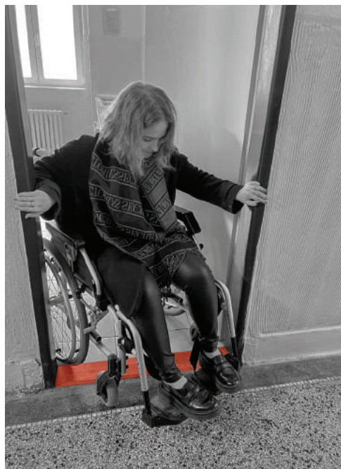
NEDOSTATOČNÁ ŠÍRKA DVERÍ PRE PRECHOD VOZIČKÁRA
