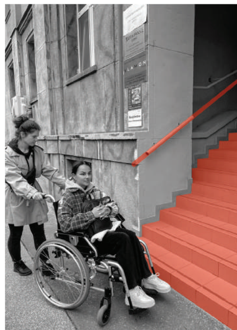
NEUMOŽNENÝ VSTUP DO BUDOVY PRE VOZIČKÁRA, NESPRÁVNE VRIEŠENÉ ZÁBRADLIE
