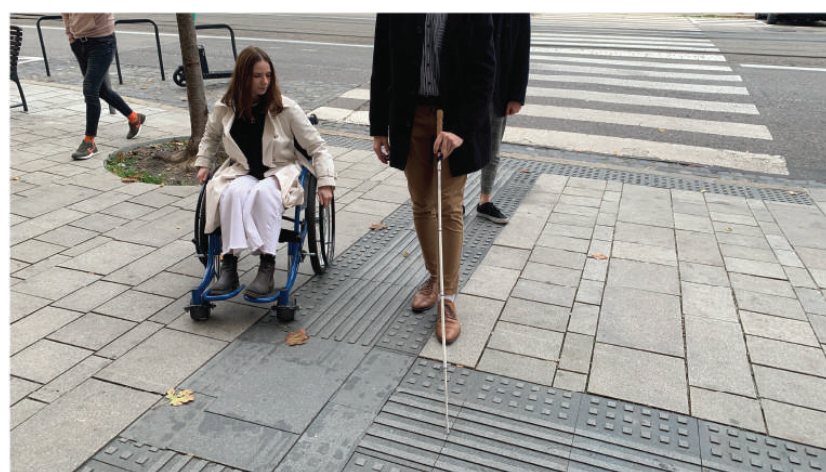
VSTUP DO BUDOVY_ NEADEKVÁTNE OZNAČENIE VSTUPU DO BUDOVY POŠTY VODIACIMI LÍNIAMI
