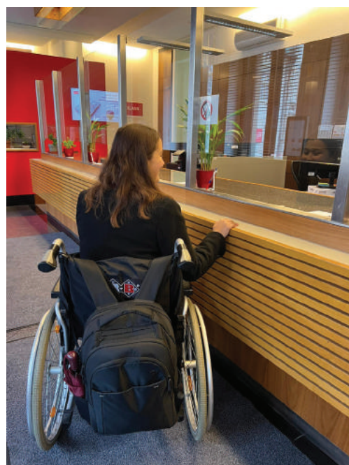
znižený pult s chýbajúcim priestorom na zasunutie nôh na vozíku
