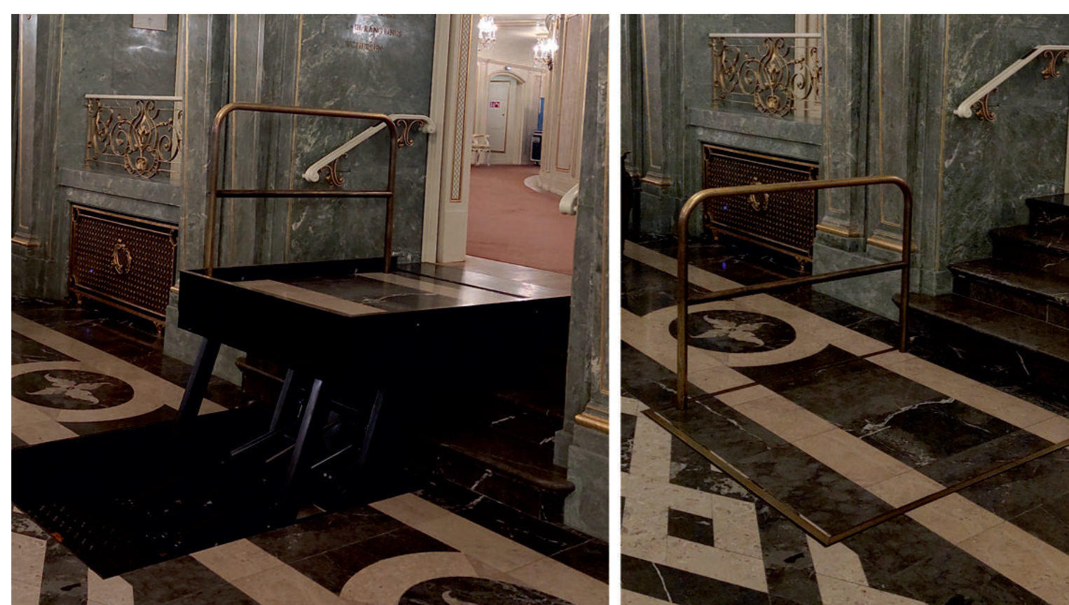
ŠTÁTNA OPERA BERLÍN / REKONŠTRUKCIA – OTVORENIE 2017 HYDRAULICKÁ ZDVÍHACIA PLOŠINA, ZAPUSTENÁ DO PODLAHY, ZACHOVÁVA PAMIAŤOVÉ HODNOTY OBJEKTU
