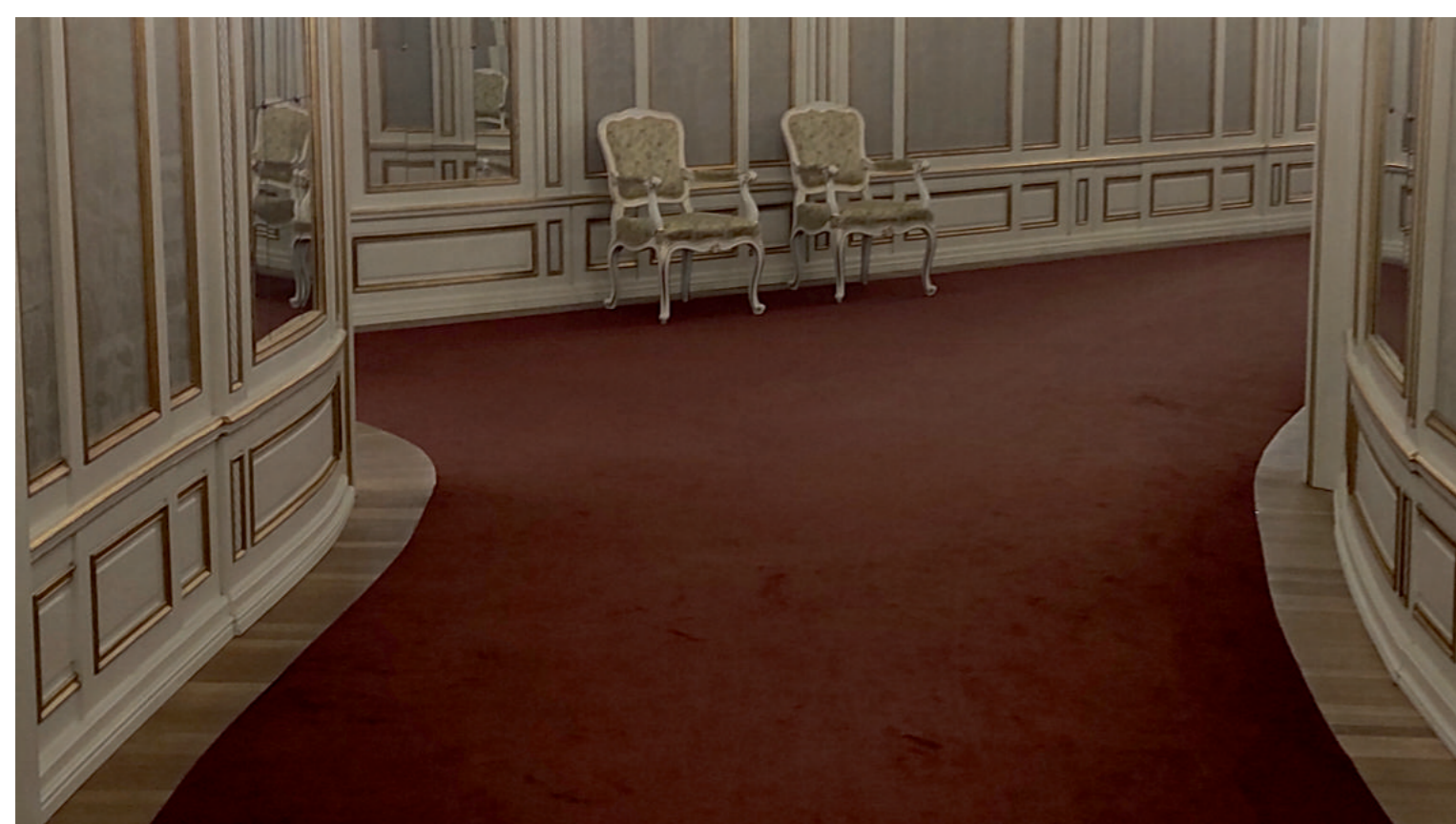
ŠTÁTNA OPERA BERLÍN / REKONŠTRUKCIA – OTVORENIE 2017 VIZUÁLNE ODDĚLENIE STĚNY A KOBERCOVEJ PLOŠINY ČEZ PÁS DREVENÉJ PODLAHOVEJ ŠTRUKTÚRY ZABEZPEČÍ LEPŠÍ VIZUÁLNY A HAPTICKÝ KONTRAST.
