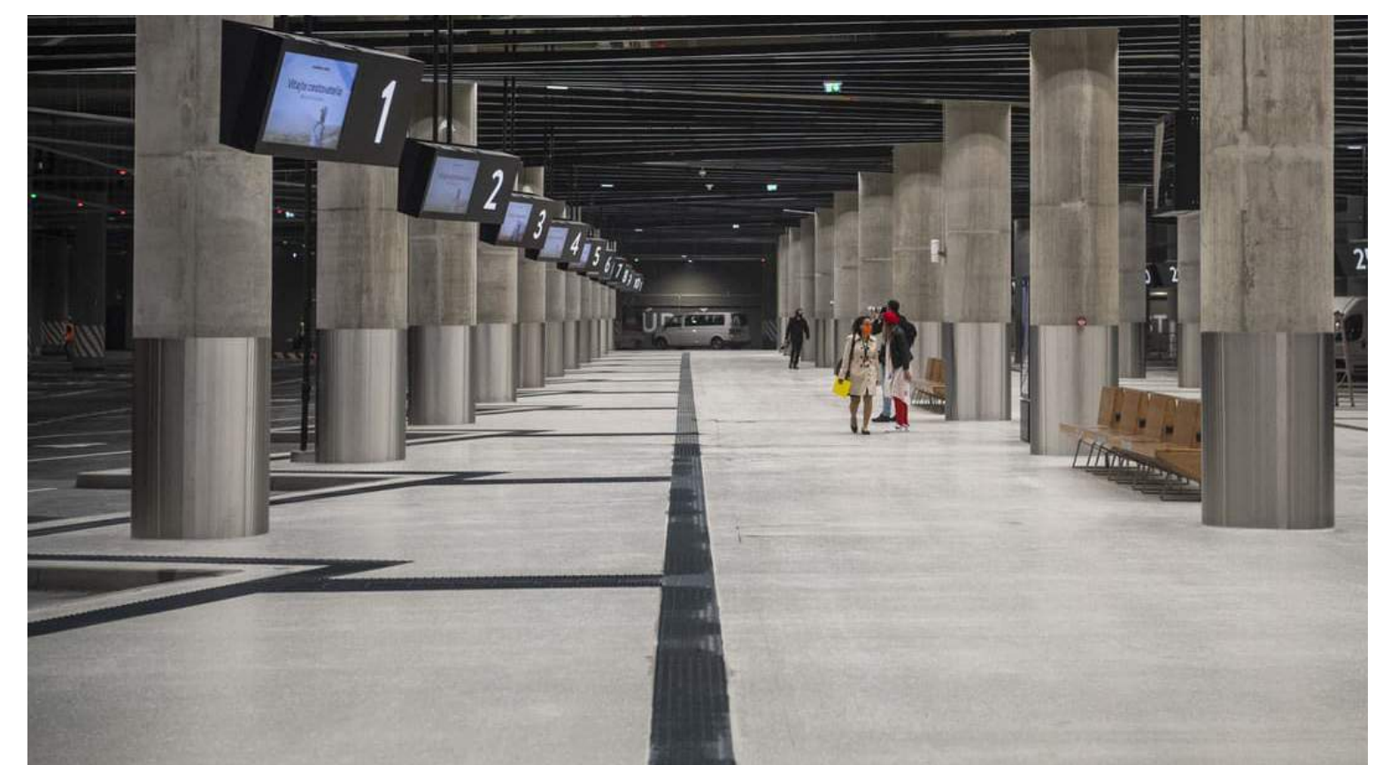
HALA S AUTOBUSOVÝMI NÁSTUPIŠTIAMI VZHLADOM NA VEĽKÉ DIMENZIE BOLI POUŽITÉ UMELE VODIACE LÍNIE
