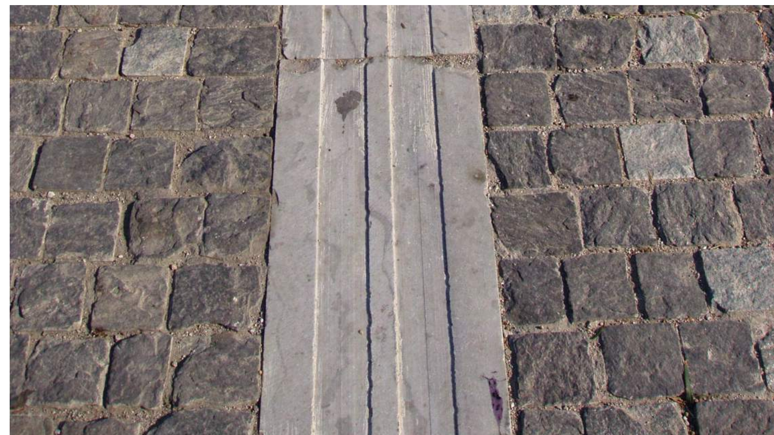
DETAIL UMELEJ VODIAČEJ LÍNIE V HISTORICKOM CENTRE - ATÉNY, GRÉCKO POUŽITIE MATERIÁLOV JE MOŽNÉ PRÍSPÔSOBIŤ LOKALITE
