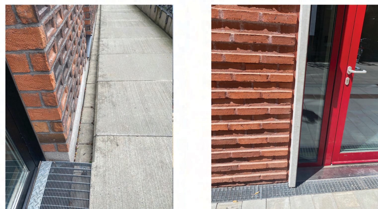
OBR. 8,9: Pred bezprahovými vstupnými dverami je vhodne vyriešené odvodnenie do prepadového žlabu, čo zvyšuje mieru bezpečnosti užívateľov v nepriaznivom počasí.
