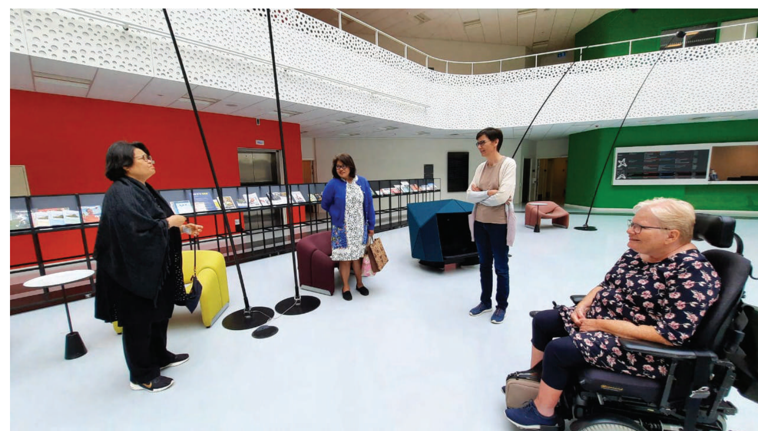
VHODNÉ AKUSTICKÉ PROSTREDIE A VÝHLAD PRE OSOBY NA VOZÍKU ZABEZPEČUJE PERFOROVANÁ ČASŤ ZÁBRADLIA
