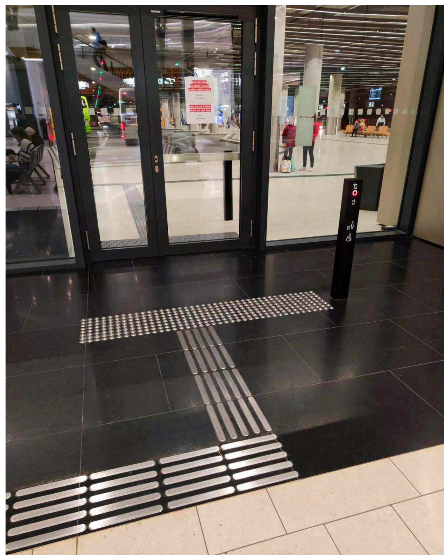
ELEKTRICKY OVLÁDANÉ DVERE VEDÚCE KU AUTOBUSOVÝM NÁSTUPIŠTIAM OVLÁDANIE DVERÍ NA STĹPIKU, SYSTÉM TAKTILNÝCH PRVKOV
