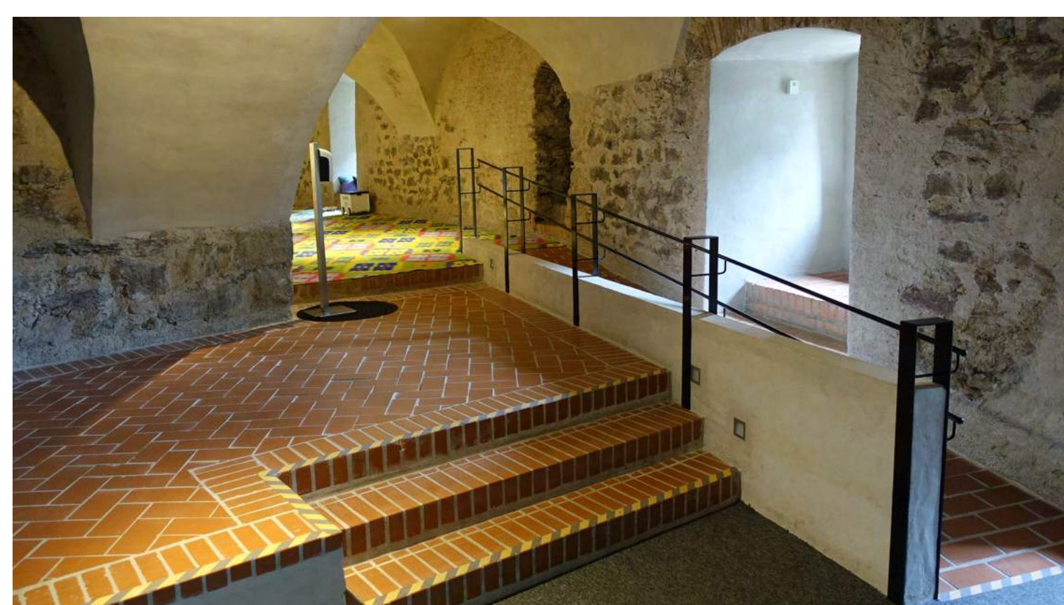
ZÁMOK SCHALLABURG. NOVÁ RAMPA VEDĽA SCHODOV. SCHALLABURG CASTLE. NEW RAMP NEXT TO THE STAIRS.
