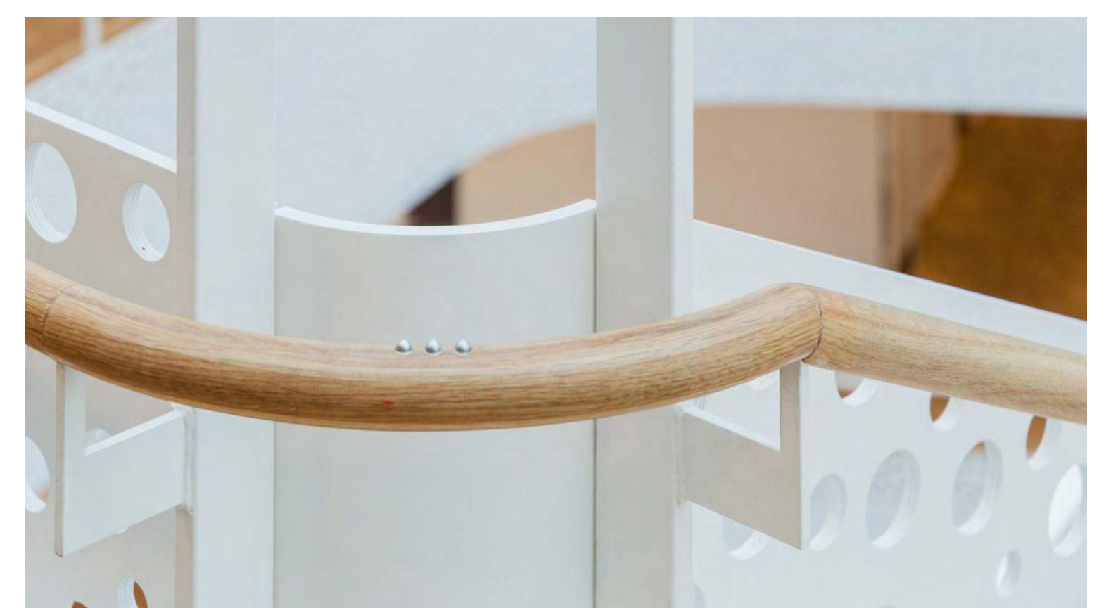
NAVÁDZACIE HAPTICKÉ ZNAČKY - GOMBÍKY POMÁHAJÚ UŽÍVATEĽOM ORIENTOVAŤ SA PO JEDNOTLIVÝCH PODLAŽIACH
