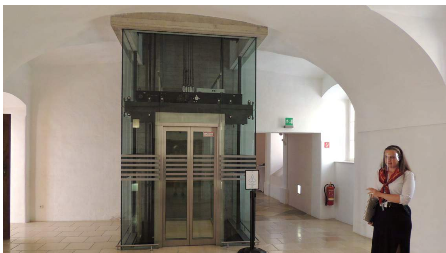
ZÁMOK SCHLOSS HOF. VÝŤAH VLOŽENÝ DO KLENBY. SCHLOSS HOF. LIFT EMBEDDED IN THE VAULT.
