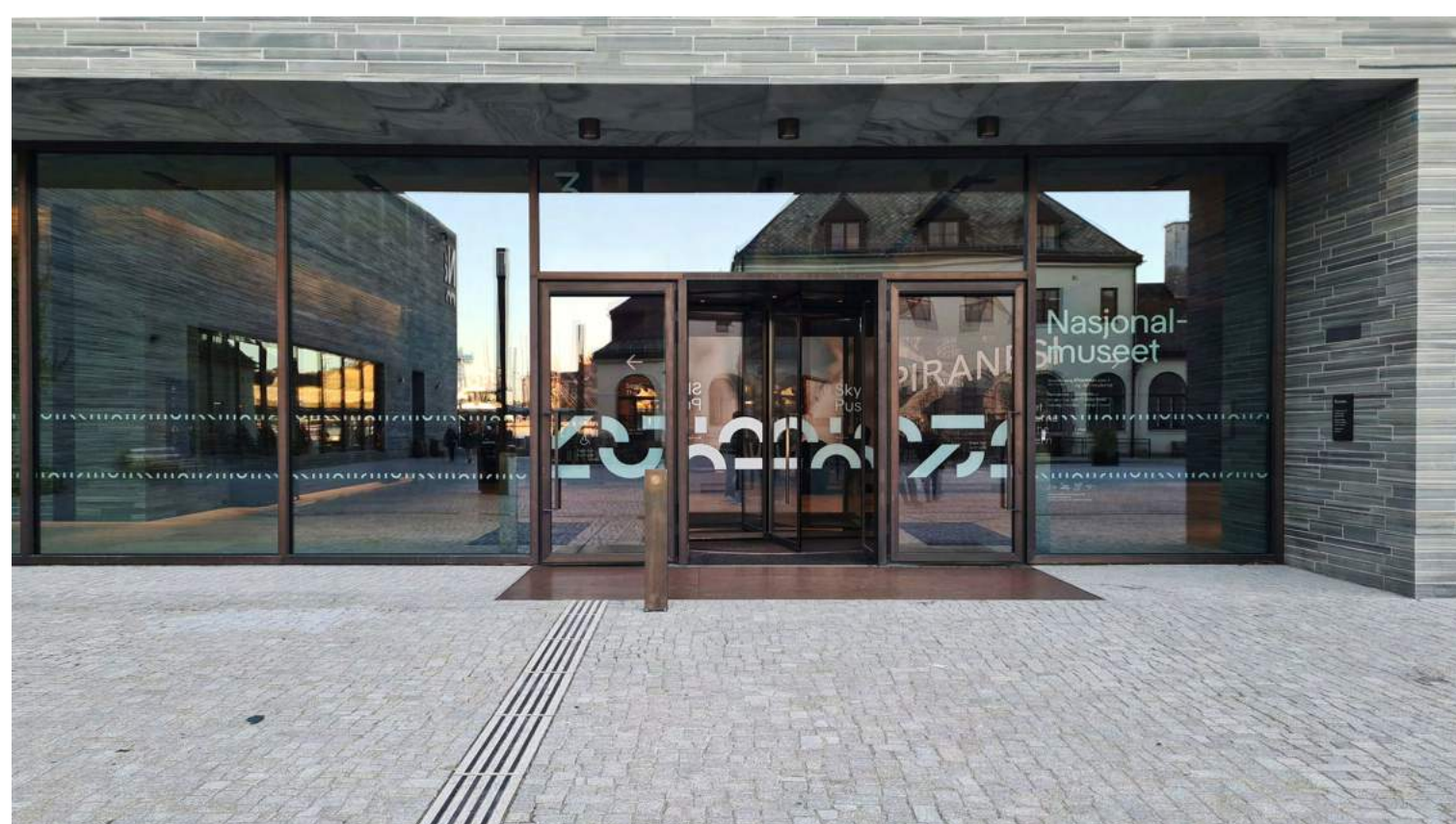
NOVÉ NÁRODNÉ MÚZEUM, OSLO, KLEIHUES + SCHUWERK GESELLSCHAFT BEZBARIÉROVO PRÍSTUPNÝ VSTUP PRE NÁVŠTEVNÍKOV S VODIACIMI LÍNIAMI
