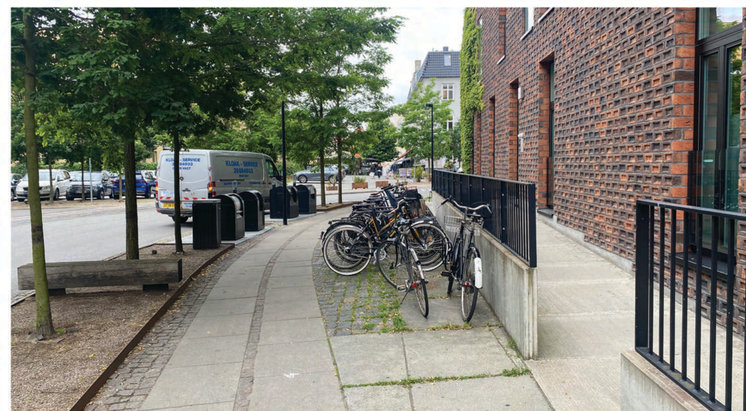
OBR. 5: Veľkoplošná kamenná dlažba chodníka je vhodná pre ľudí s kočkmi, vozíčkmi a pod. kontrastné pásy zo žulových kociek sú vhodnou orientačnou pomôckou a vymedzujú priestor pre osadenie mestského mobiliáru.
