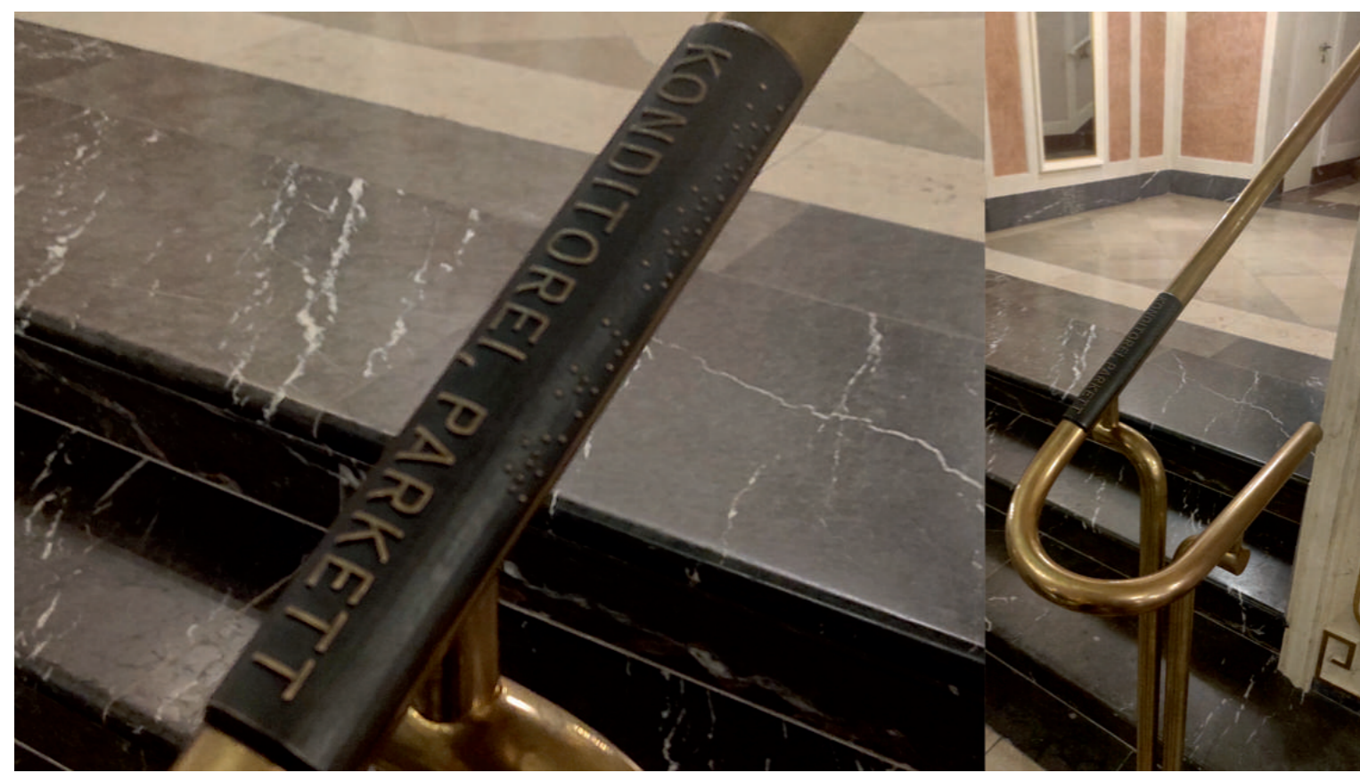
ŠTÁTNA OPERA BERLÍN / REKONŠTRUKCIA – OTVORENIE 2017 RELIÉFNE A BRAILLOVO PÍSMO NA HORIZONTÁLNO M ZÁBRADLÍ
